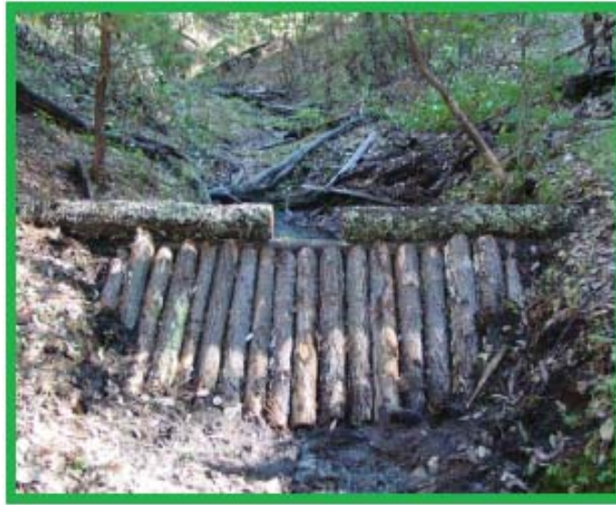
Fig. 30. Imagen de una presa de morillos.
