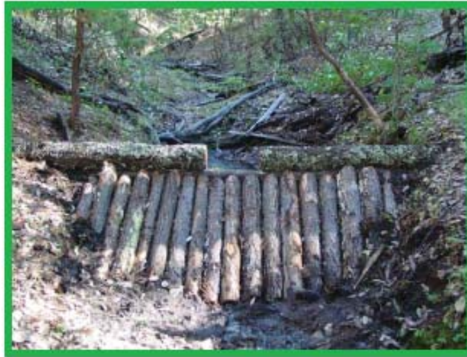
Fig. 30. Imagen de una presa de morillos.
