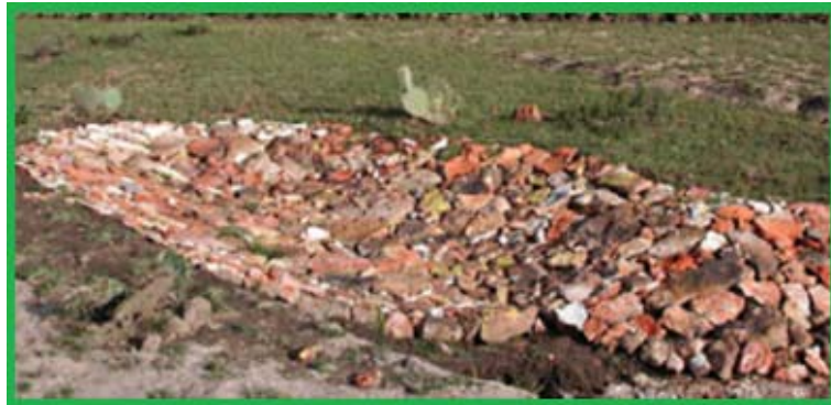
Fig. 9. Cabeceo de una cárcava.
