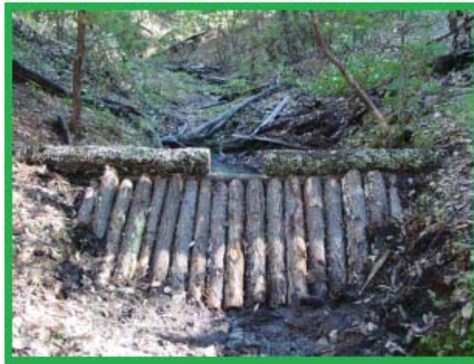
Fig. 29. Imagen de una presa de morillos.
