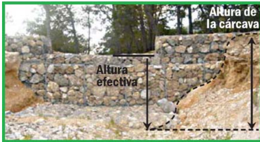
Fig. 31. Esquema de una presa de gavión.
