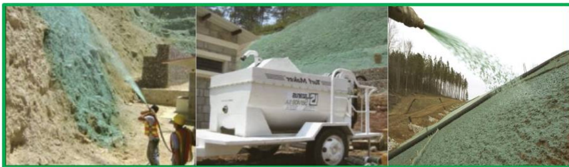
Fig. 36. Imágenes del proceso de hidrosiembra.
