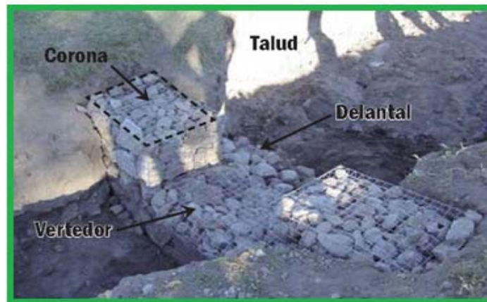
Fig. 29. Presa de malla ciclónica esquematizada.
