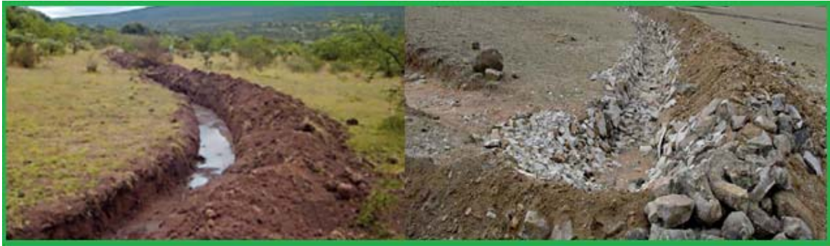
Fig. 9 Se ilustra una zanja de derivación recién excavada a la izquierda y una vez cabeceada para evitar arrastre de sedimentos a la derecha.
