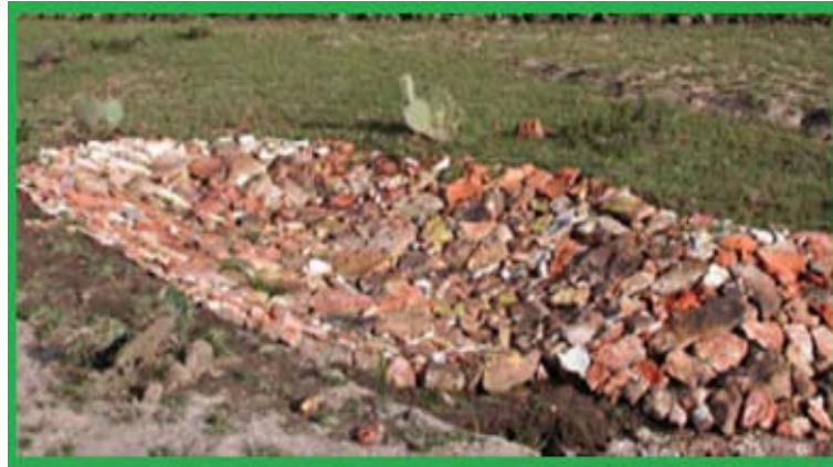
Fig. 9. Cabeceo de una cárcava
