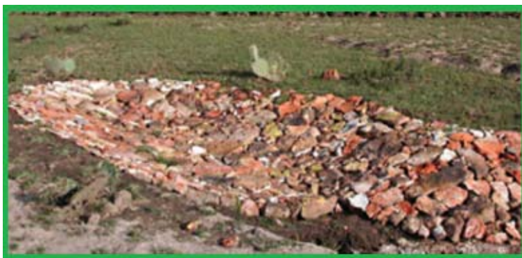
Fig. 8. Cabeceo de una cárcava.
