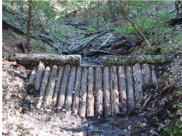
Fig. 30. Imagen de una presa de morillos.
