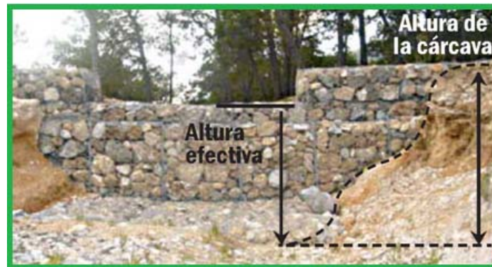
Fig. 31. Esquema de una presa de gavión.
