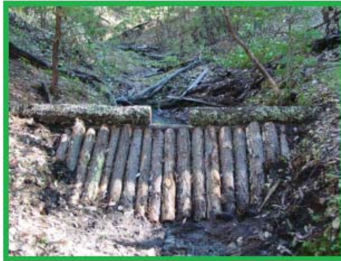
Fig. 29. Imagen de una presa de morillos.
