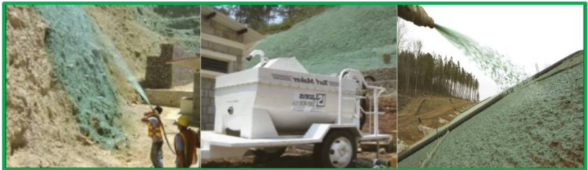
Fig. 37. Imágenes del proceso de hidrosiembra.
