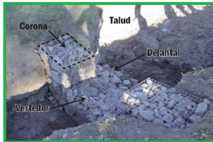
Fig. 29. Presa de malla ciclónica esquematizada.
