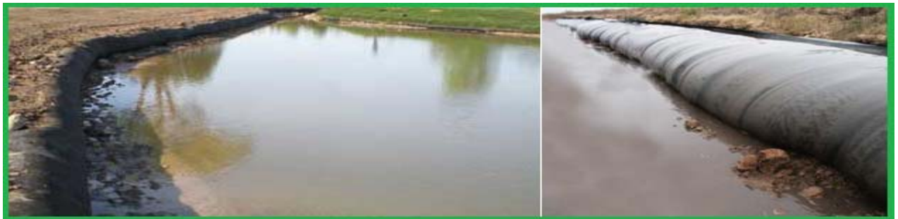
Fig. 12. Uso de geotubos para protección de los márgenes de un cauce.
