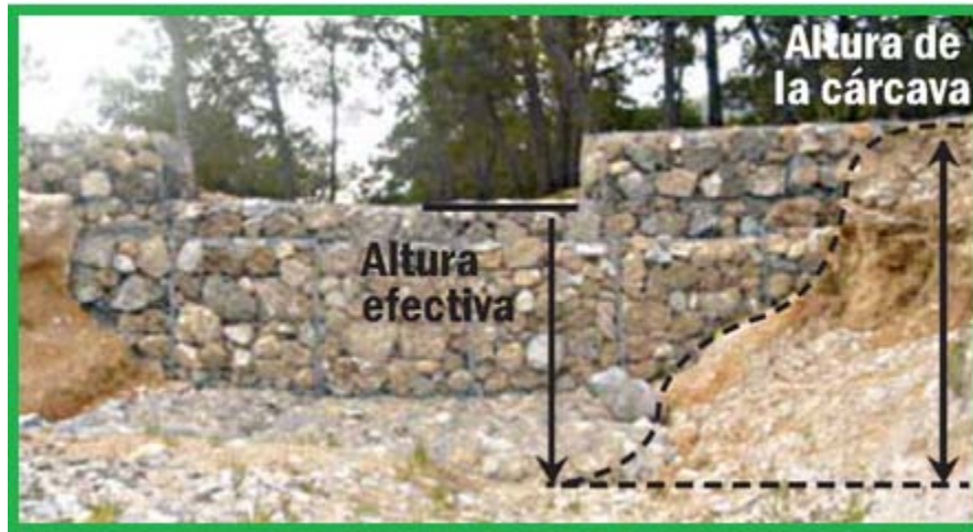
Fig. 32. Esquema de una presa de gavión.
