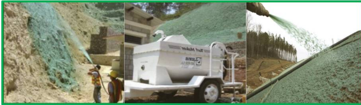
Fig. 37. Imágenes del proceso de hidrosiembra.
