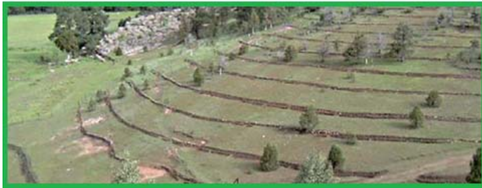
Fig. 17. Técnica de terrazo por formación sucesiva.
