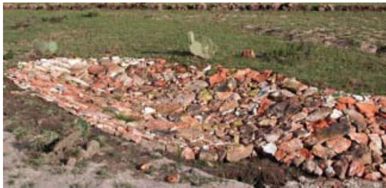
Fig. 9. Cabeceo de una cárcava
