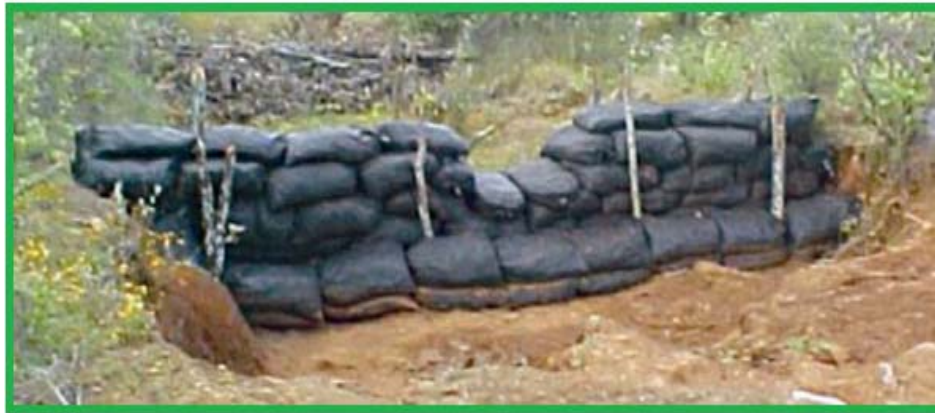
Fig. 26. Imagen de una presa de geocostal.
