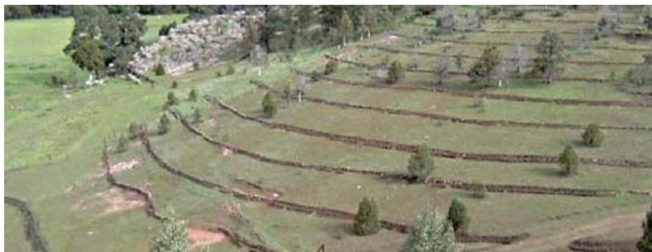
Fig. 17. Técnica de terrazo por formación sucesiva.
