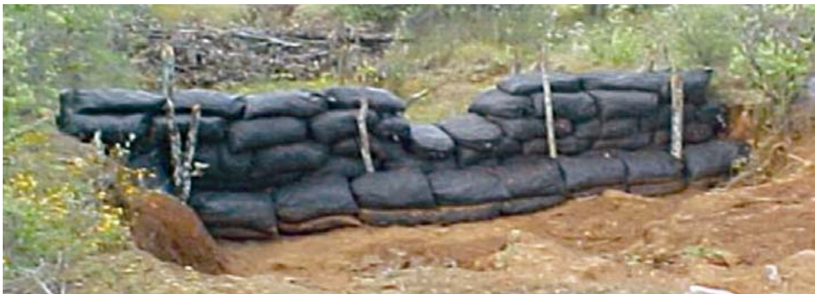
Fig. 27. Imagen de una presa de geocostal.
