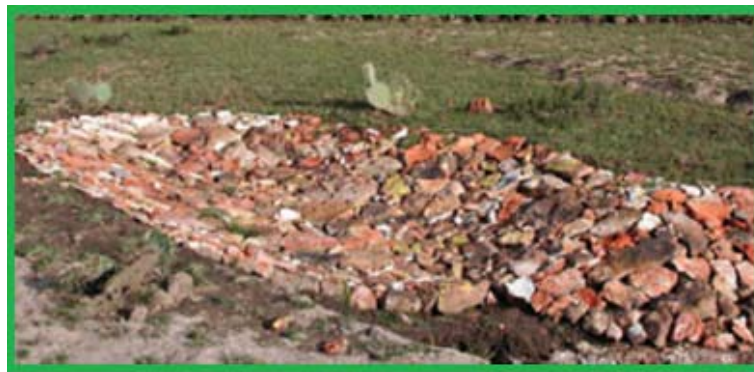
Fig. 9. Cabeceo de una cárcava.
