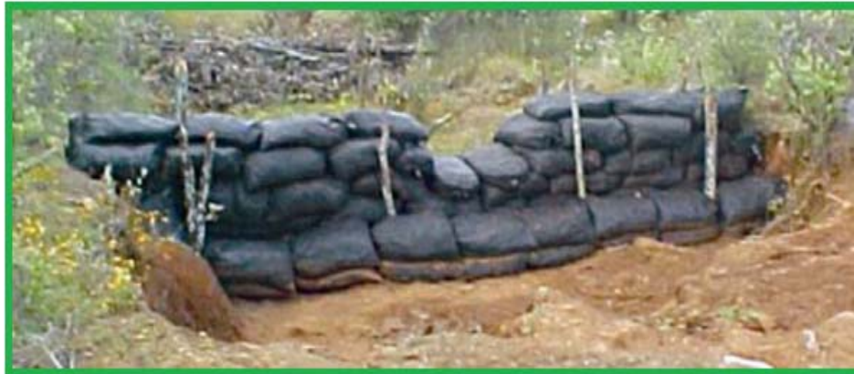
Fig. 27. Imagen de una presa de geocostal.
