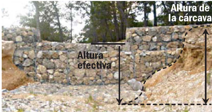
Fig. 32. Esquema de una presa de gavión.
