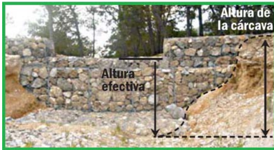
Fig. 32. Esquema de una presa de gavión.
