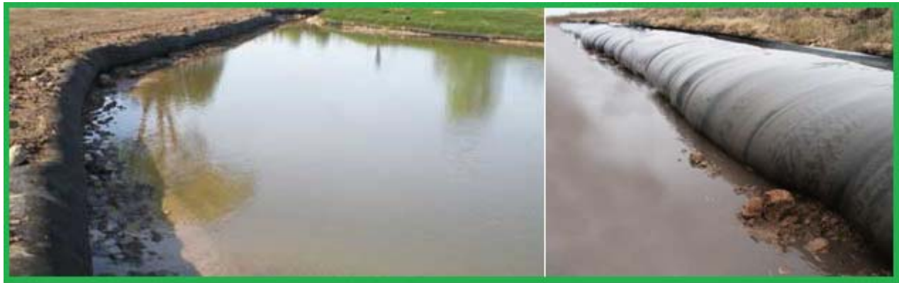
Fig. 11. Uso de geotubos para protección de los márgenes de un cauce.
