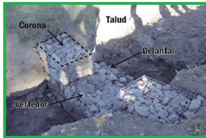
Fig. 28. Presa de malla ciclónica esquematizada.
