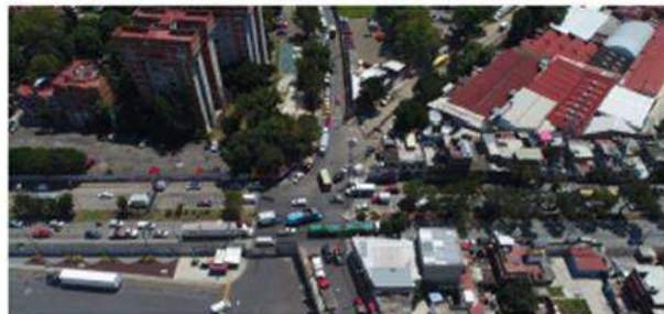
Imagen 55. Avenida Ceylán y Av. Maravillas, al norponiente del polígono
