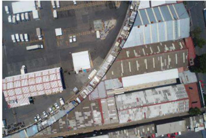
Imagen 03. Asentamientos irregulares a lo largo de la vía férrea
