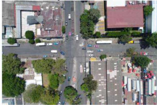
Imagen 162. Vista aérea de cruce
