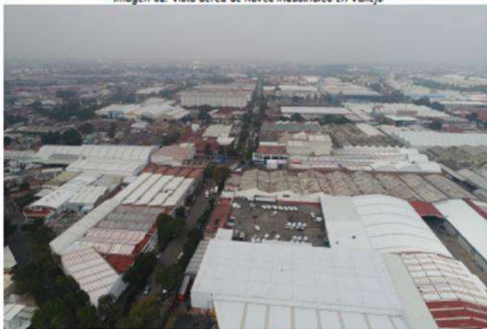
Imagen 32. Vista aérea de naves industriales en Vallejo
