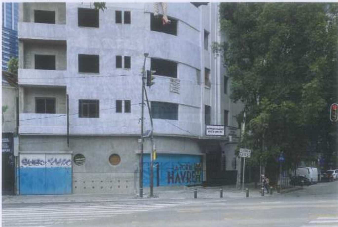
Edificio en calle Havre esquina Av. Insurgentes
