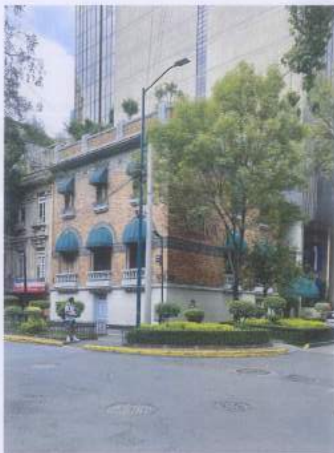
Edificio en calle Liverpool esquina Ámbar
