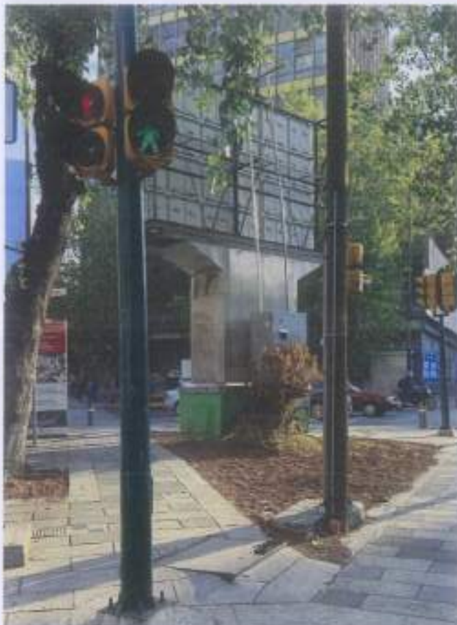
Espacio remanente entre Av. Insurgentes y calles Niza y Liverpool
