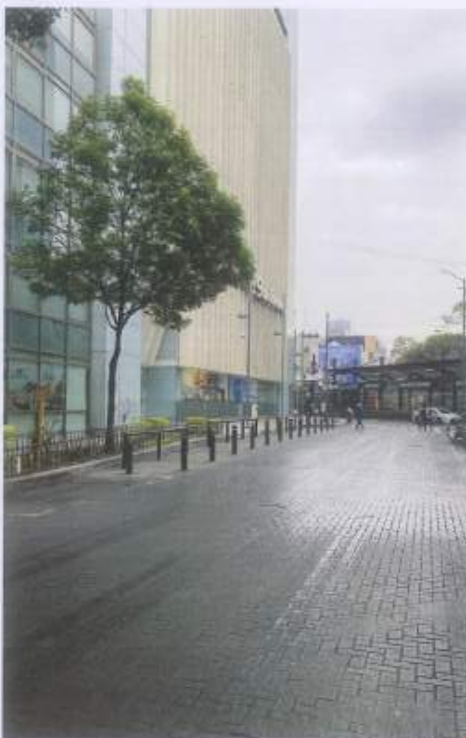
Metrobús Hamburgo y Reforma 221 desde calle Hamburgo
