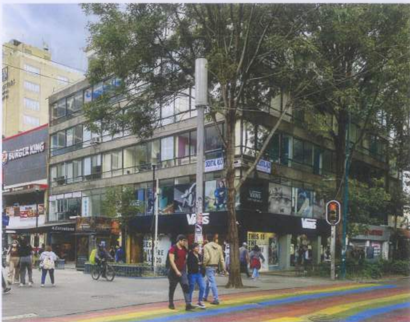
Edificio en calle Génova esquina Hamburgo
