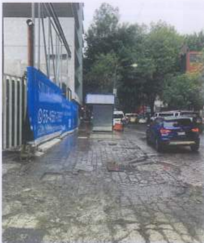
Banqueta de calle Hamburgo, entre Florencia y Cerrada Hamburgo
