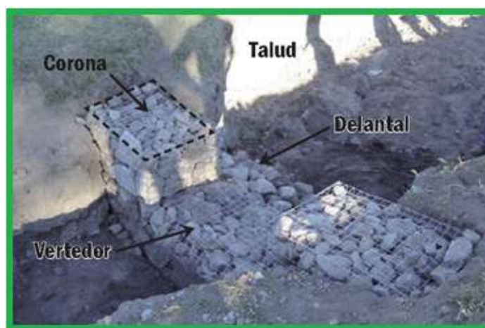
Fig. 30. Presa de malla ciclónica esquematizada.
