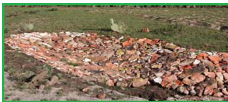
Fig. 9. Cabeceo de una cárcava.
