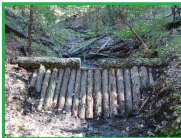
**Fig. 31.** Imagen de una presa de morillos.
