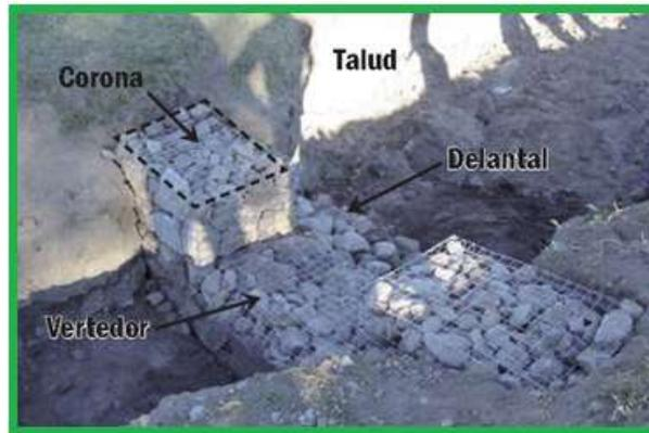
**Fig. 30.** Presa de malla ciclónica esquematizada.
