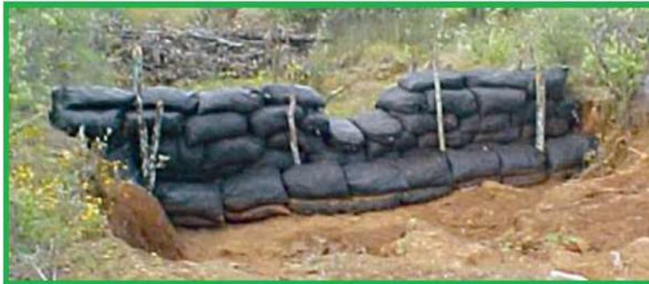
**Fig. 28.** Imagen de una presa de geocostal.
