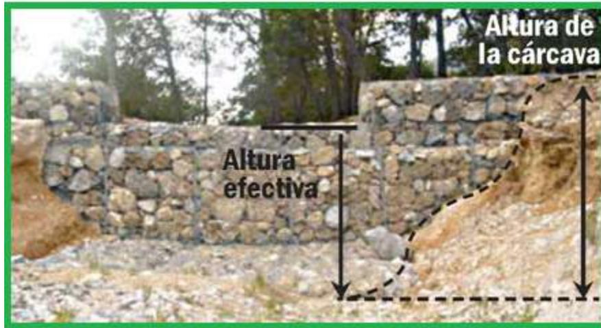
**Fig. 33.** Esquema de una presa de gavión.
