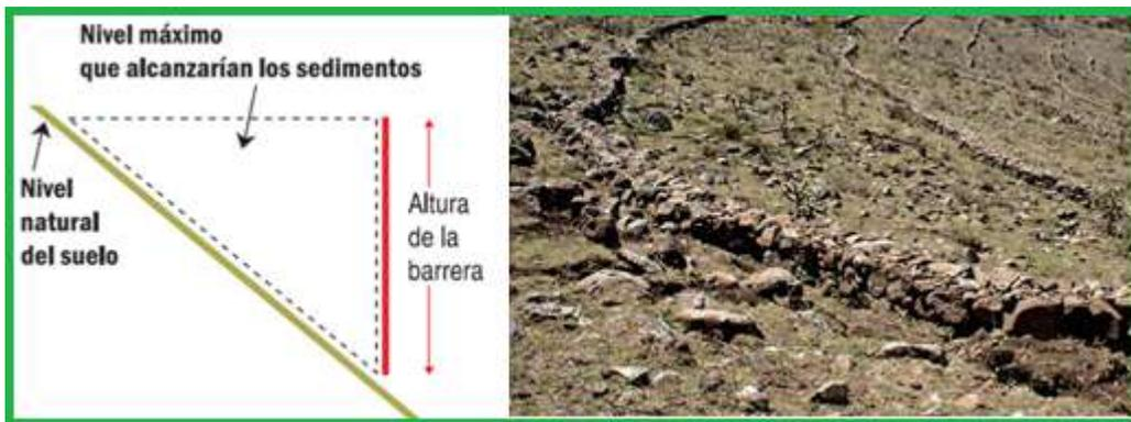
Fig. 12. Bardas construidas sobre curvas de nivel.
