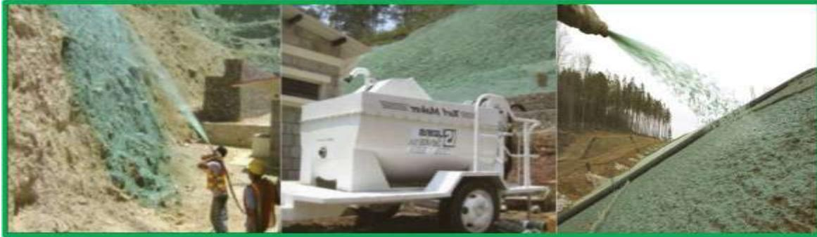
**Fig. 38.** Imágenes del proceso de hidrosiembra.
