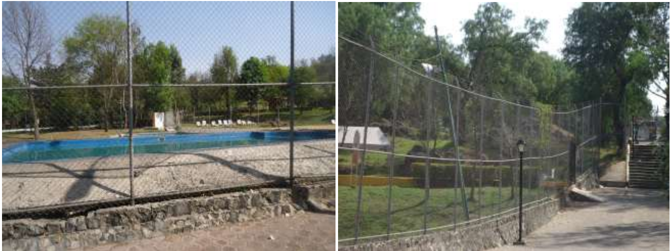
Figura 7. Playa artificial y barda perimetral.
