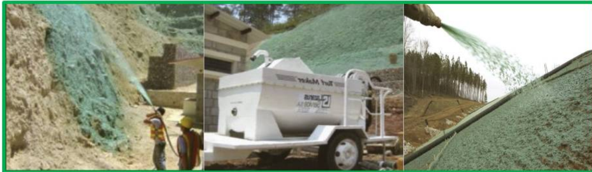
Fig. 37. Imágenes del proceso de hidrosiembra.
