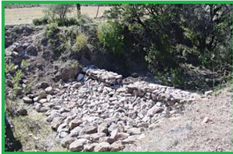
Fig.31. Imagen de unas presas de piedra.
