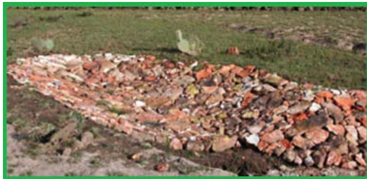
Fig. 9. Cabeceo de una cárcava.
