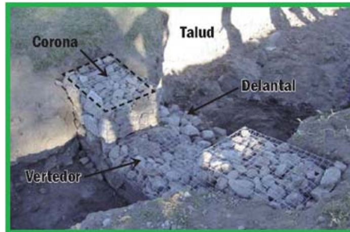
Fig. 29. Presa de malla ciclónica esquematizada.
