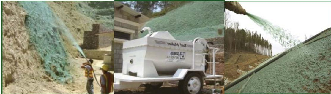
**Fig. 37.** Imágenes del proceso de hidrosiembra.
