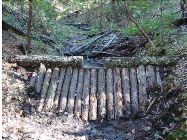
**Fig. 30.** Imagen de una presa de morillos.
