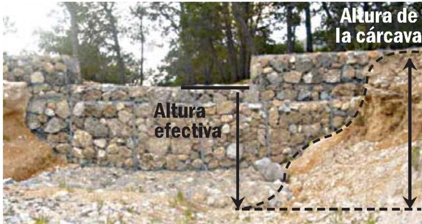
**Fig. 32.** Esquema de una presa de gavión.
