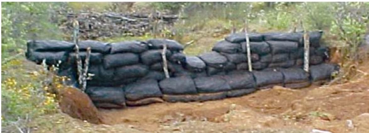
**Fig. 27.** Imagen de una presa de geocostal.
