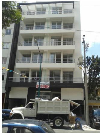
Fotografía 17. Obras ejecutadas utilizando la Norma General de Ordenación número 26
