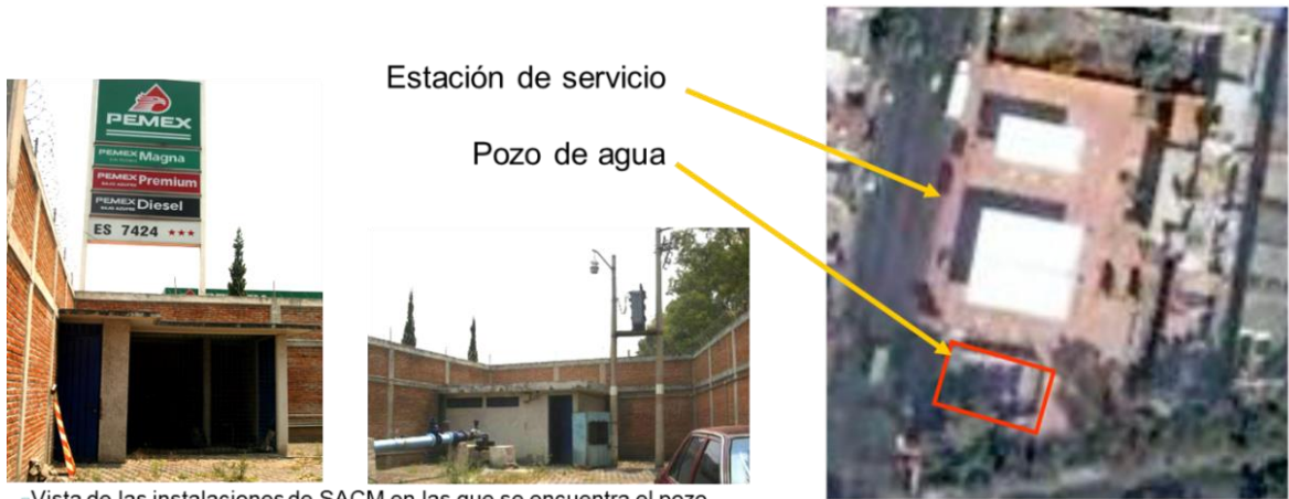
■ Vista de las instalaciones de SACM en las que se encuentra el pozo
