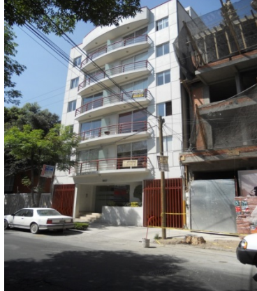
Figura 17. Inmueble habitado de seis niveles ubicado en San Francisco 38, Actipan
