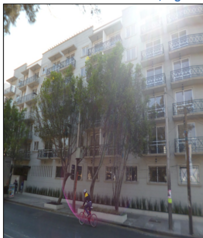
Figura 12. Vista general del inmueble ubicado en calle 2 número 203, Agrícola Pantitlán
