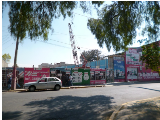
Figura 11. Vista general del inmueble ubicado en calle 1 número 143, Agrícola Pantitlán
