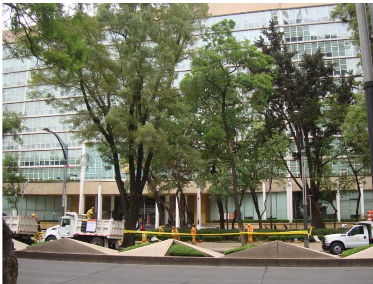
Figura 10. Trabajos de saneamiento de arbolado
