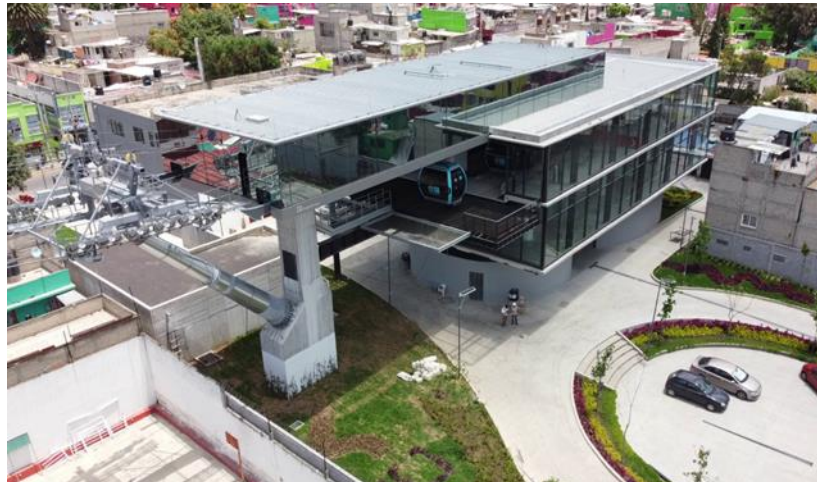
Imagen fotográfica de las obras del cable bus línea 1.
