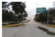
Imagen fotográfica del puente terminado en avenida Río Churubusco esquina con canal de Tezontle (12/11/2014).
