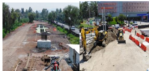
Imágenes fotográficas del avance de la obra (2/9/2020).
