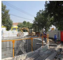
Imagen fotográfica del túnel en el tramo las Torres-Observatorio (7/11/2017).
