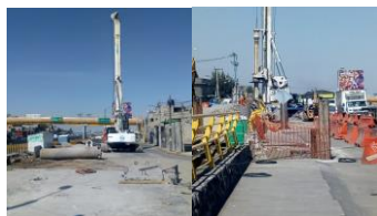
Imágenes fotográficas de la obra desde autopista México-Puebla y Jorge Negrete (26/11/2019).
