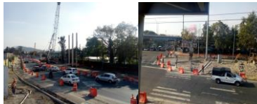
Imágenes fotográficas de la obra desde Circuito Interior y Eje 6 Sur (26/11/2019).
