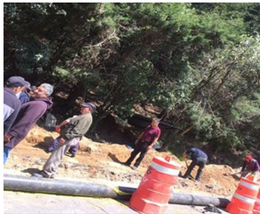
Imágenes fotográficas de la obra (13/2/2020).
