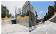
Imágenes fotográficas de la obra terminada (20/9/2016).
