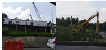
Imágenes fotográficas de la obra desde Periférico Sur (16/8/2020).
