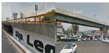
Imagen fotográfica del puente terminado desde avenida Revolución esquina con Molinos (3/5/2016).
