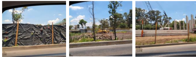
Imágenes fotográficas de la obra desde Periférico Sur (5/6/2020).
