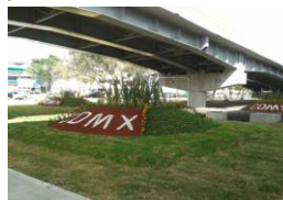
Imagen fotográfica del puente terminado en avenida Río Churubusco esquina con Plutarco Elías Calles (12/11/2014).
