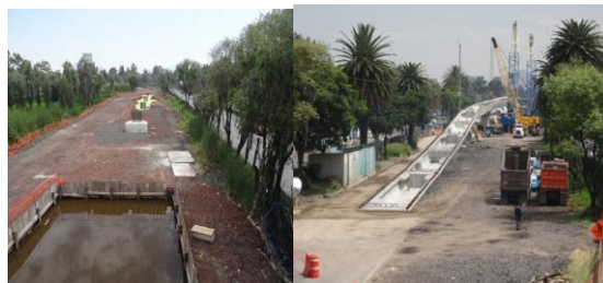
Imágenes fotográficas del avance de la obra (30/9/2020).
