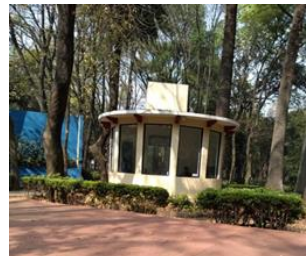
Obra del módulo de seguridad concluida (1/3/2019).
