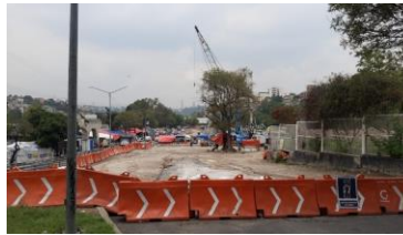
Imagen fotográfica de la vista del predio y material del Cetram Observatorio (22/7/2021).
