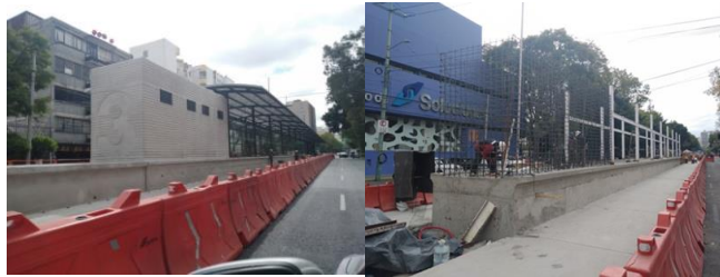
Imagen fotográfica del avance de la construcción en estaciones (18/11/2020).
