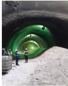
Imagen fotográfica de la entrada de lumbrera de avenida de las Torres (7/11/2017).
