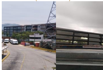
Imágenes fotográficas donde se muestra el avance de la obra (17/8/2020).
