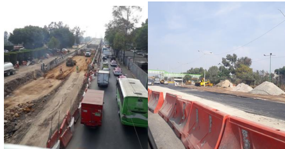
Imágenes fotográficas de la subida y bajada del puente en Av. Lázaro Cárdenas en dirección al Sur (17/1/2020).
