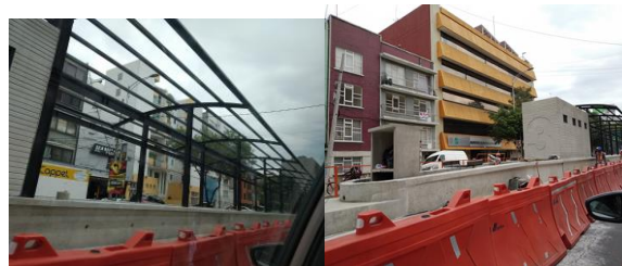
Imagen fotográfica del avance de la construcción de las estaciones (13/8/2020).
