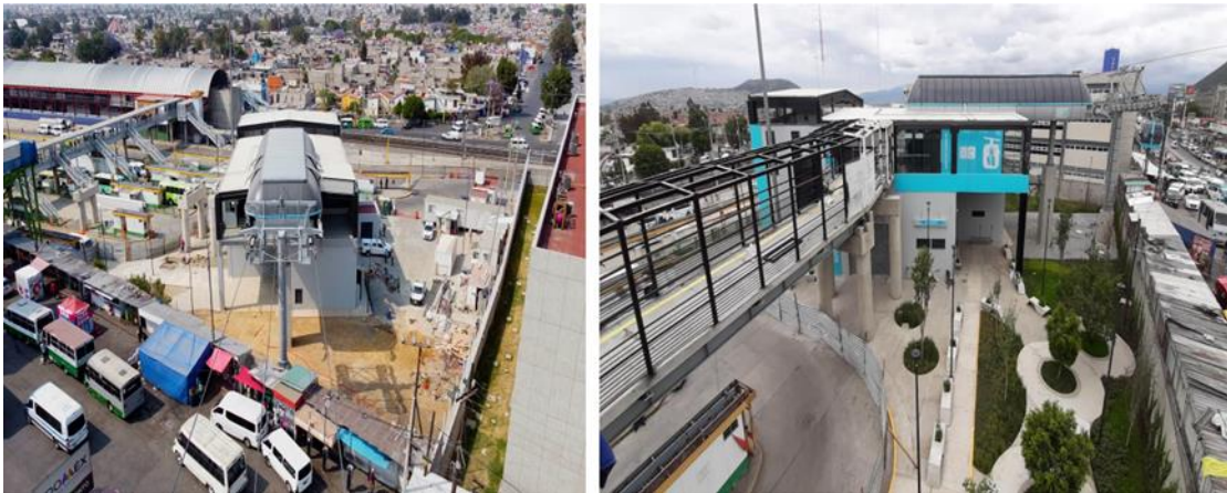
Imágenes fotográficas de las obras del cable bus línea 2.
