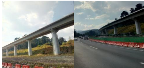
Imágenes fotográficas de los avances de las obras en la Carretera Federal México-Toluca (27/12/2019).
