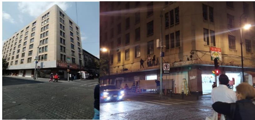
Estructura metálica instalada en la marquesina, 10 de febrero de 2021 (izquierda) y retiro de la estructura metálica, 18 de octubre de 2021 (derecha).
