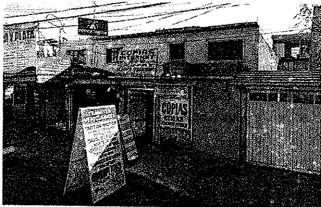
Imagen No. 3 Inmueble objeto de investigación, el cual consta de 2 niveles de altura.
